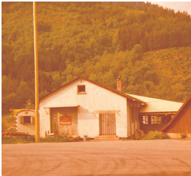
Die Gemeindehalle während des Umbaus
